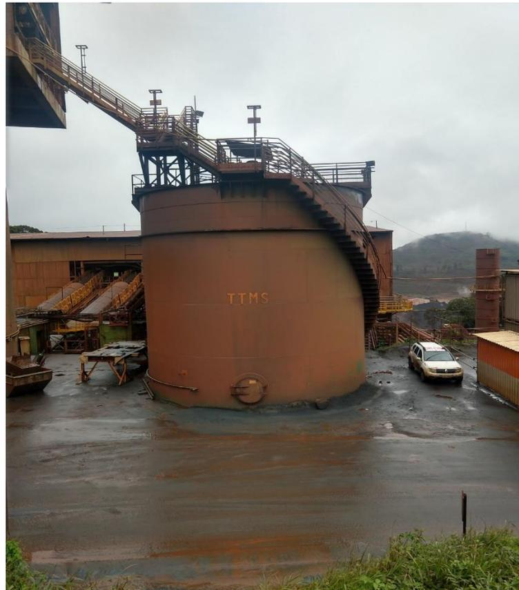
Figura 3: Tanque usado para armazenamento de polpa de minério de ferro
