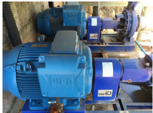
Figura 2 – Bombas responsáveis pela alimentação do reservatório.
