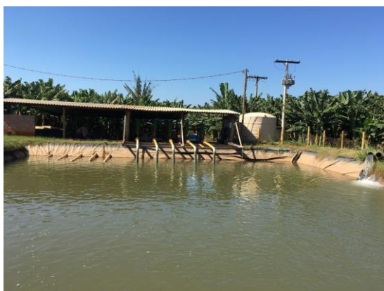
Figura 3 – Reservatório e bombas de saída.
