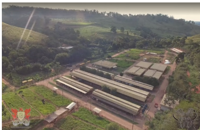
Figura 1 – Vista aérea da UEPE-GL.
