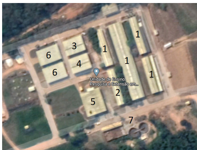
Figura 2 – Vista espacial da UEPE-GL (1-Pátios free stall ; 2-Garagem; 3-Bezerreiro; 4-Pátio de experimentos; 5-Sede administrativa e sala de ordenha; 6-Laboratórios de pesquisa; 7-Tanques chorumeira).
