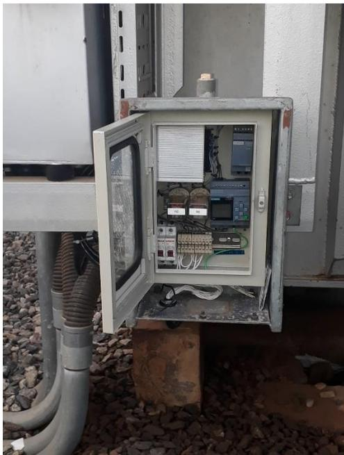
Figura 11 – Instalação do PLC na SE Frei Inocêncio
